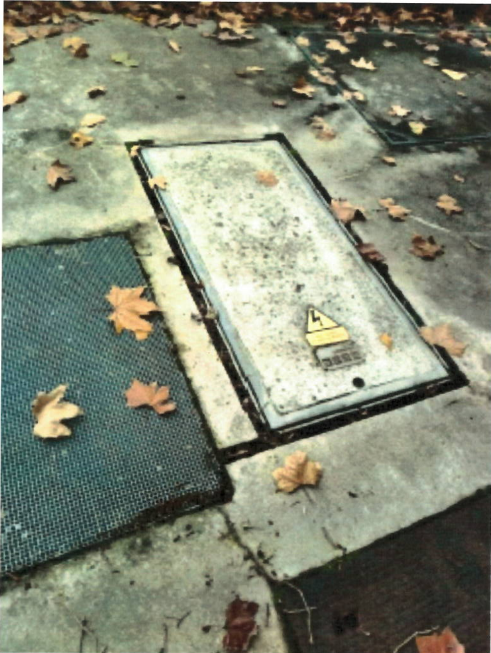
Foto 1: Portezuela de acceso al centro de seccionamiento subterráneo.
